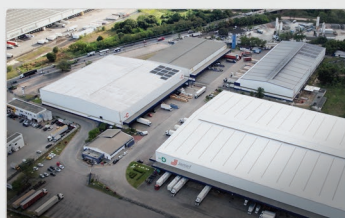
CONDOMÍNIO INDUSTRIAL AJAM-I
